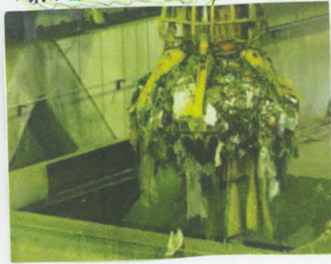
④ クレーンでゴミをえやすしくしている
